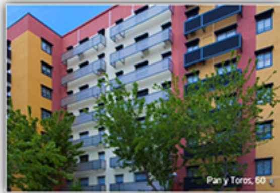
Aislamiento térmico en fachada
