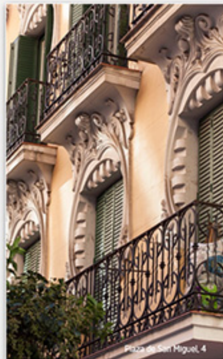
Limpieza y pintura en fachada
