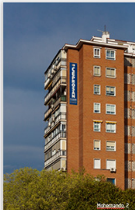
Hidrofugado en fachada de ladrillo
